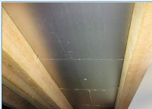
Рисунок 1: Внутри скатной крыши со стропилами и слоем изоляции
