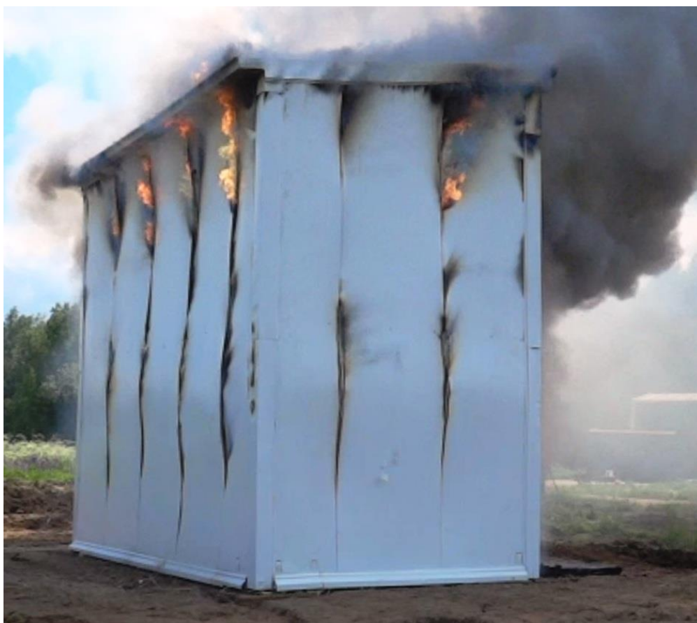
Рисунок 11. Пример горения газов на 14-й минуте при испытании по ГОСТ Р 56076-2014 12 двухэтажного фрагмента здания из сэндвич-панелей с минеральной ватой (рис. авт.)
