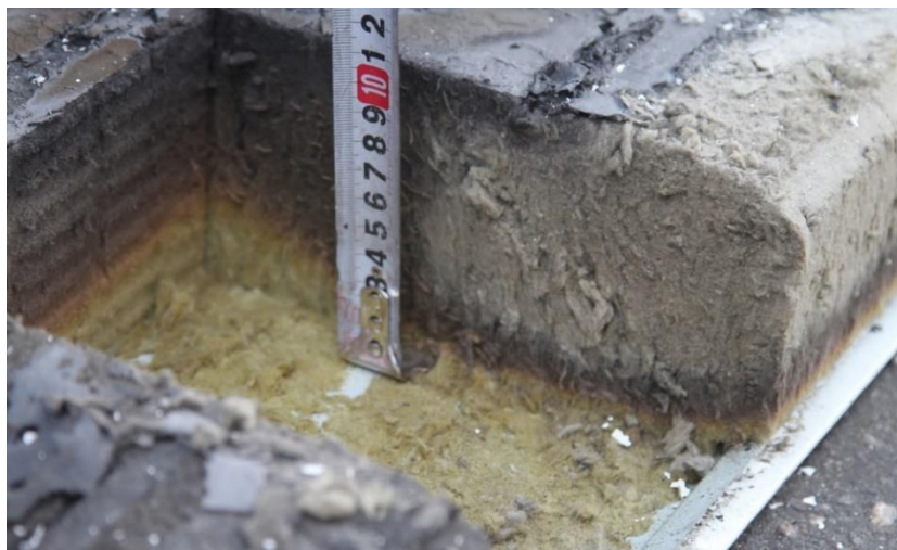
Рисунок 17. Повреждения типа MB2 при испытании на огнестойкость стены из сэндвич-панелей по ГОСТ Р 56076-2014 (время огневого воздействия – 30 мин). Стальная обшивка демонтирована (рис. авт.)
