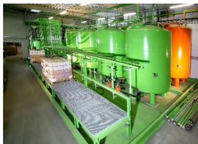
Складские резервуары с полной обвязкой для хранения полиэфиров, изоцианатов, смол и пентана
