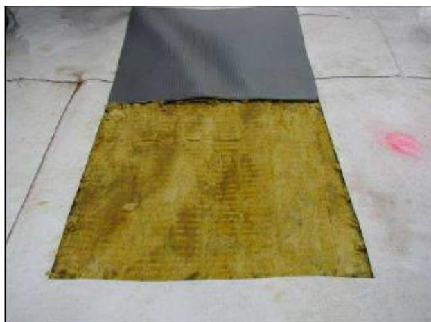
Рис. 22. Место протечки 3 и в основном сухой изоляционный материал (воздействию влаги подверглась верхняя поверхность)
