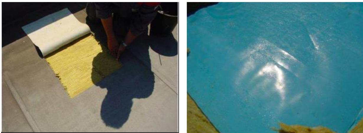
Рис. 14 и 15. Места снятия образцов и конденсат на пароизоляционной пленке
